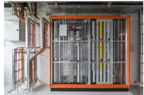
Etagenverteilung Elektro
