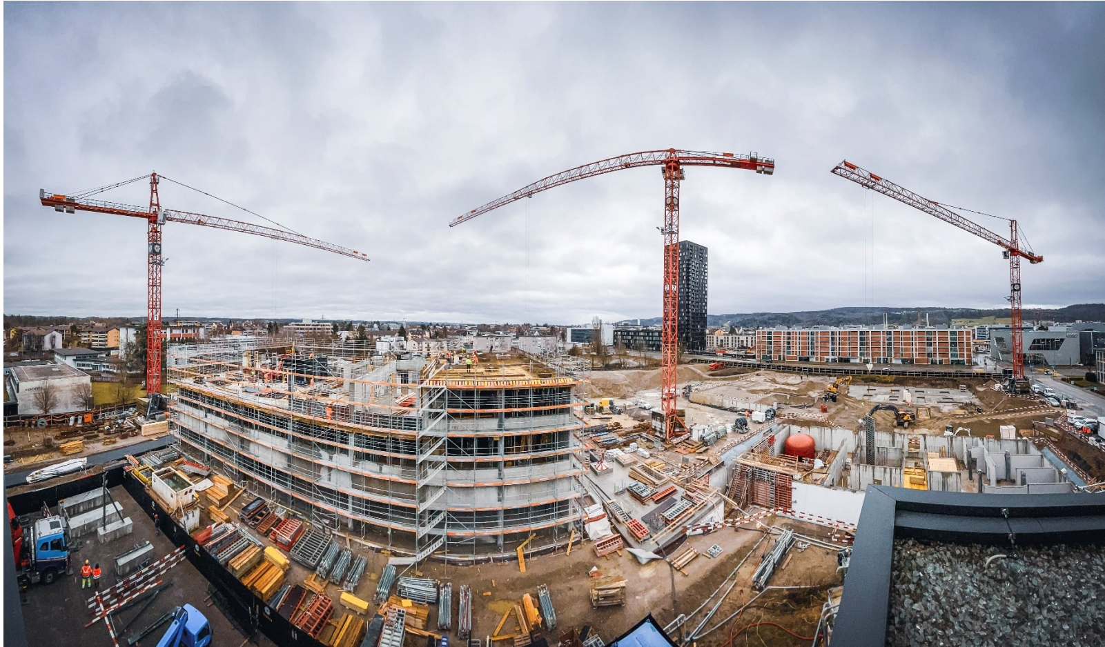
Chantier en février 2022
