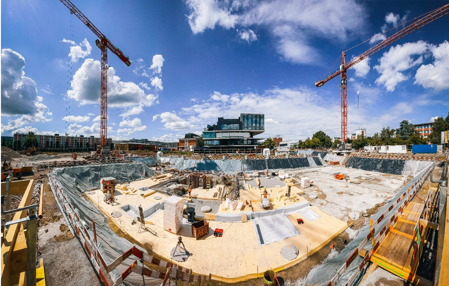
Fondations du bâtiment LB août 2021
