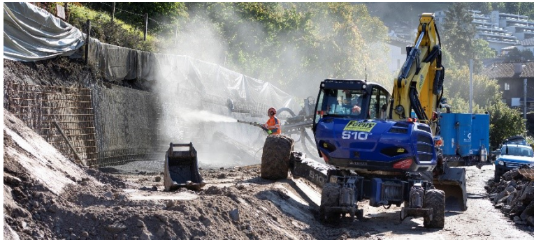
Prestations de génie civil et de machines de chantier
